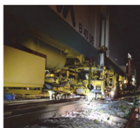
大型保守作業機械による 軌道整備
