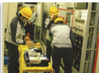
変電所設備の検査
