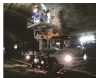
トンネル検査
