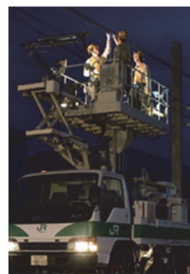
【夜間作業の様子】
