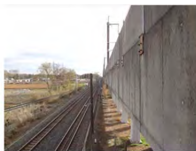
コンクリート橋（高欄部）
