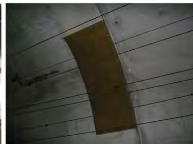
内面補強工の例
