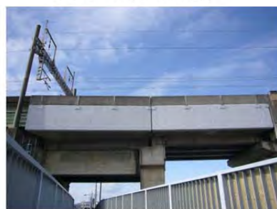
高欄部 表面改修工の例
