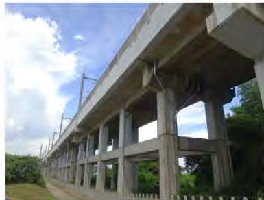
コンクリート橋（外側）
