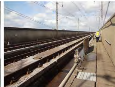
コンクリート橋（内側）
