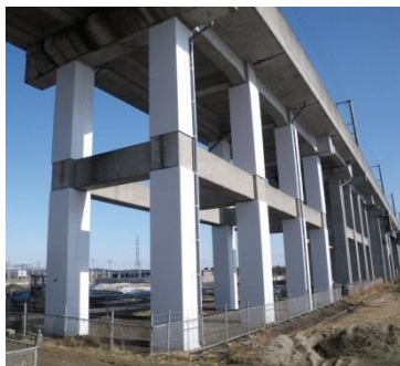
高架橋耐震補強
