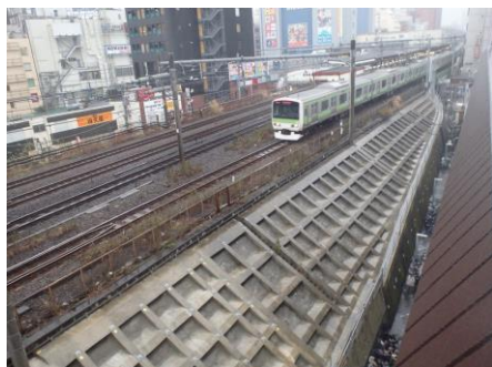
盛土耐震補強
