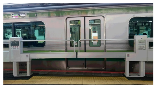
スマートホームドア® (横浜線町田駅)
