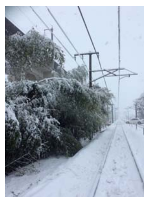
宇都宮線西那須野～那須塩原駅間での倒竹（2016年1月17日発生）
