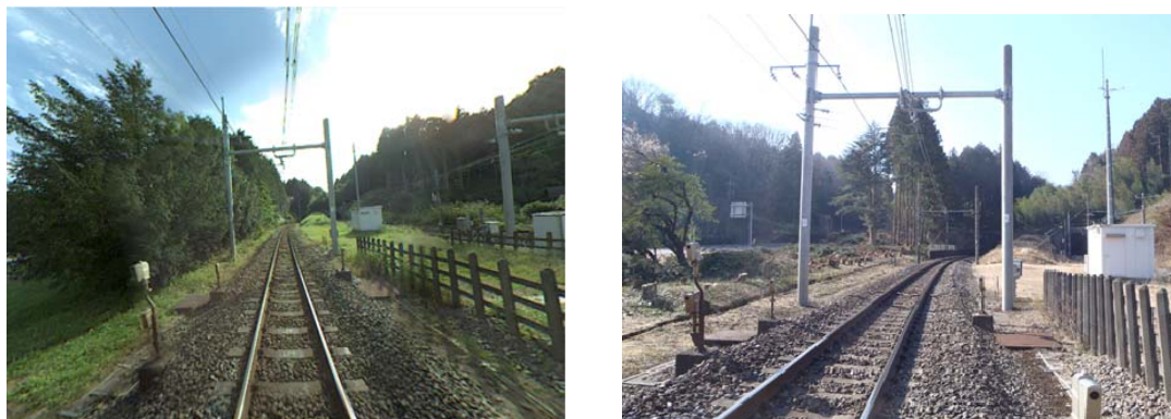
宇都宮線矢板～野崎駅間の針生トンネル付近の伐採状況（左が伐採前、右が伐採後）
