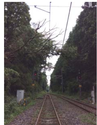
日光線文挾駅構内での倒木 (2015年8月4日発生)
