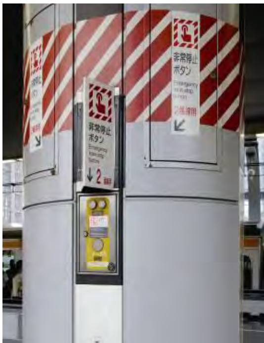
【非常停止ボタン】
