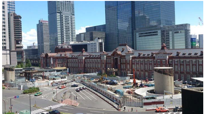
完成が近づく丸の内駅舎前広場の様子(2012年8月現在)
