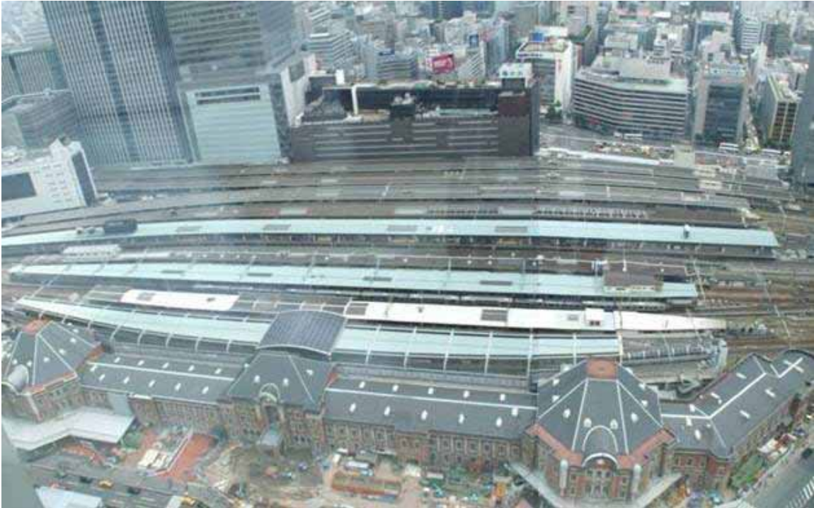
東京駅ホーム屋根の現況写真
