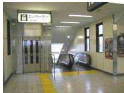
バリアフリー設備整備
