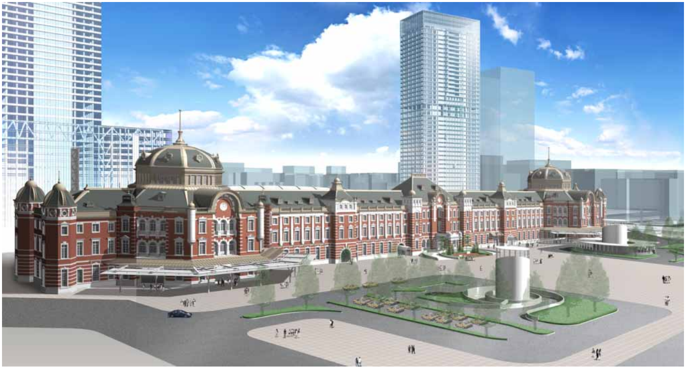
外観イメージ(北ドーム側より)
