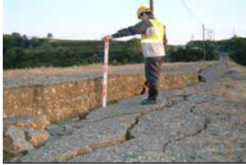
被害状況: 堤体天端にクラック及び段差が発生
