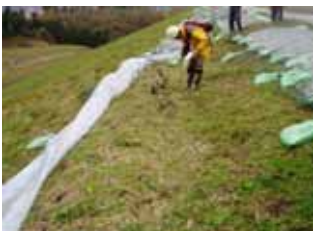
被害状況: 堤体の沈下、法面表層部にクラック等が発生
