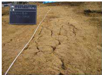
被害状況: 堤体天端にクラックが発生。法面表層部のリップラップのすべり
