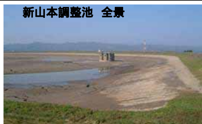
被害状況: 堤体天端にクラックが発生。法面表層部のリップラップのすべり
