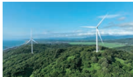
西目西ノ沢風力発電所
