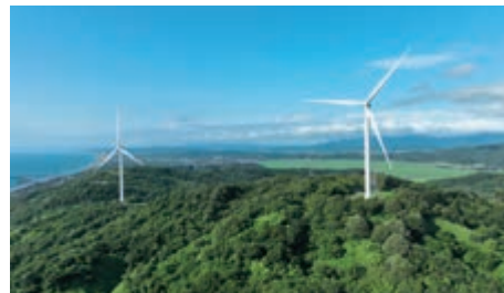
西目西ノ沢風力発電所
