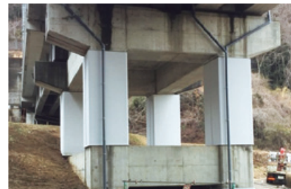
耐震補強対策
