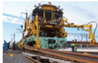
新幹線のレール交換
