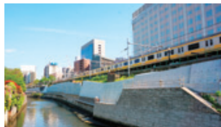
盛土部の耐震補強対策
