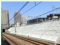
耐震補強対策
