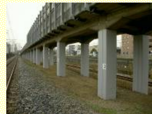
高架橋柱耐震補強
