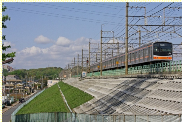
降雨防災対策(のり面補強)
