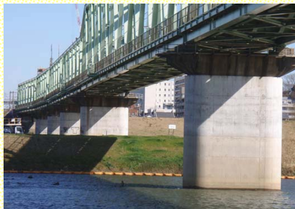
橋脚耐震補強
