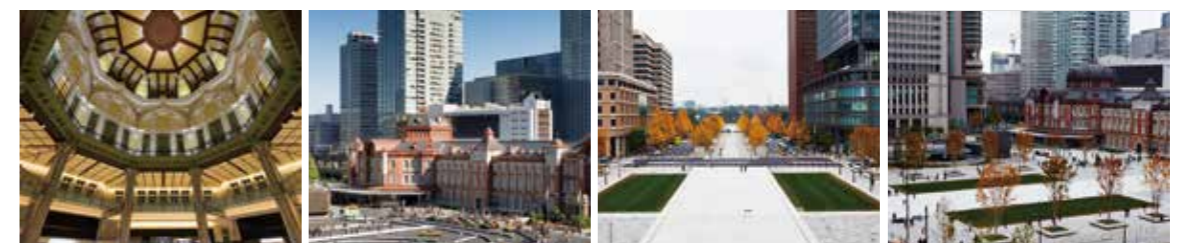
2012年 復原後の南ドーム 2012年 駅舎保存・復原後 2017年 ホテルからの景色 2017年 駅前広場完成後
