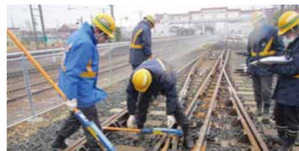
技能教習所の線路設備
