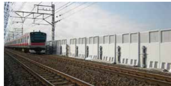
京葉線 潮見～新木場間
