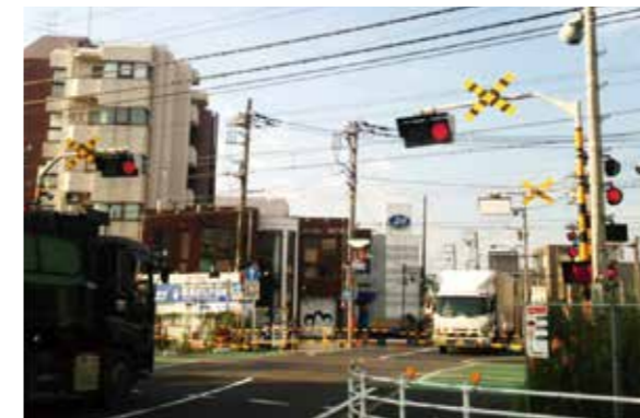
警報機を道路の上方に設置
