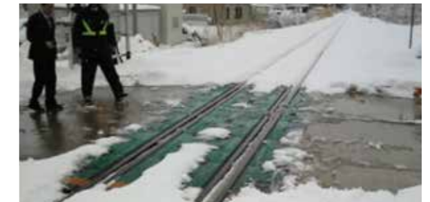
降雪地帯で交通量が多い踏切等に対してロードヒーティング等を整備
