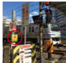
踏切支障報知装置
