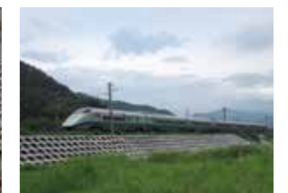
盛土のり面工(吹付砕工)
