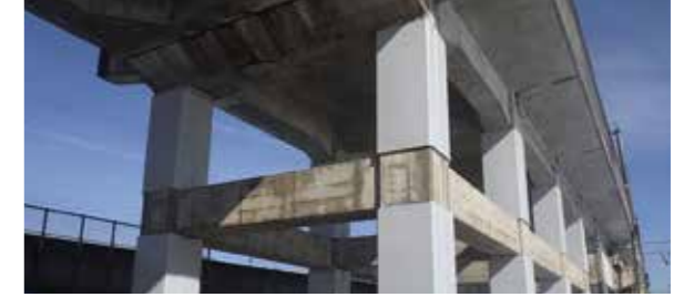
耐震補強対策
