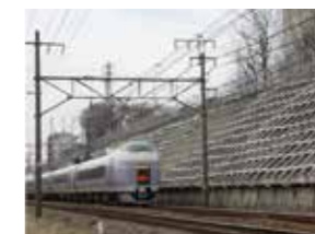
切取のり面工(吹付砕工)
