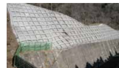
自然斜面防護工(吹付砕工)
