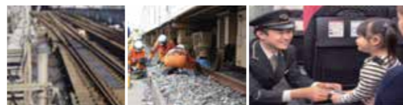
ポイント不転換対策 (融雪マット) 総合復旧訓練 接客のプロとしての応対
