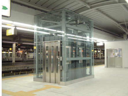
新宿駅中央線(快速)ホーム
