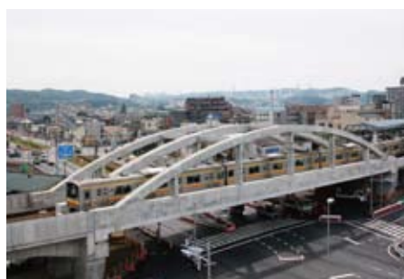
南武線稲城長沼駅付近高架化
