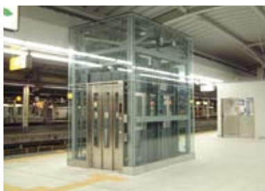
新宿駅中央線(快速)ホーム
