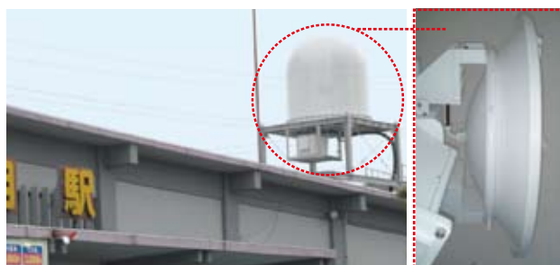
羽越本線余目駅屋上に設置されたドップラーレーダー
