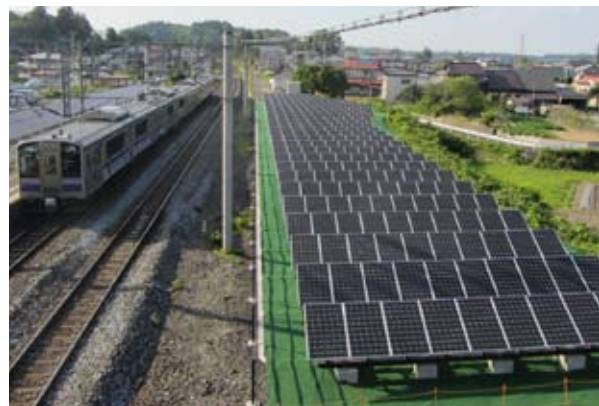
平泉駅に設置された太陽光発電パネル
