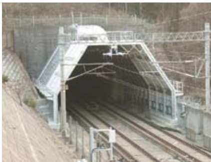
ダクト付トンネル緩衝工
