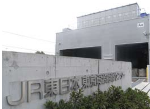
JR東日本東京資源循環センター
