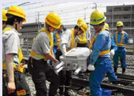
分岐器(ポイント)を転換するモーターの交換訓練
