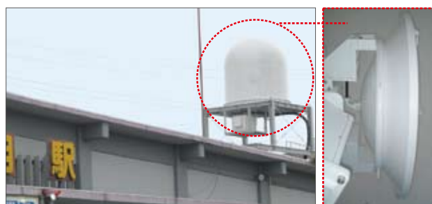
羽越本線・余目駅屋上に設置された ドップラーレーダー、 ドップラーレーダー本体
