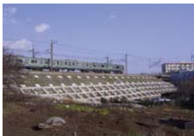
コンクリート製の格子砕工
