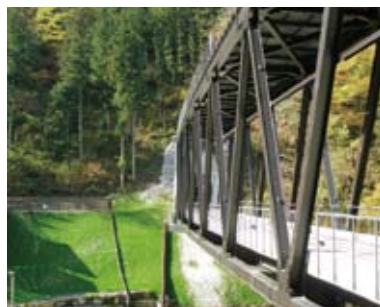
白岩沢橋りょう張芝工
