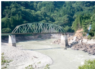
第5只見川橋りょう
