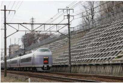
切取のり面工 (吹付砕工)
