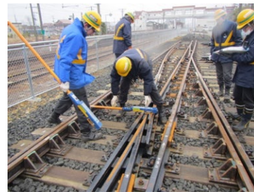
技能教習所の線路設備
