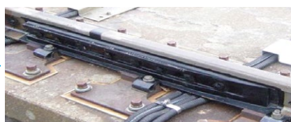
改良後の接着絶縁継目
