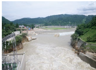
第6只見川橋りょう
