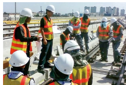
軌道メンテナンス
