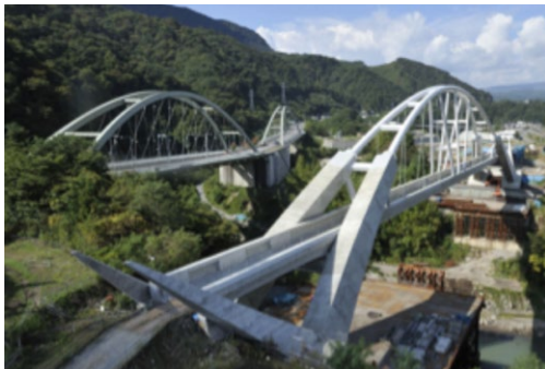
吾妻線 第三吾妻川橋りょう
