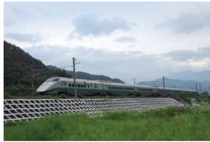
盛土のり面工 (吹付砕工)
