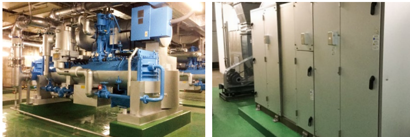
設備更新後の高効率ターボ冷凍機と空調機
