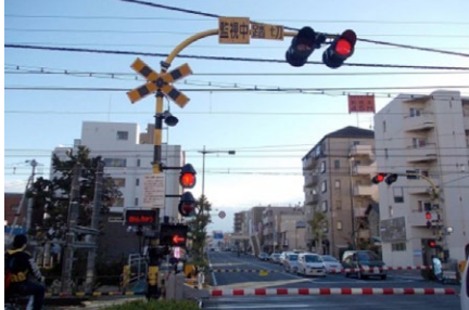
警報機を道路の上方に設置。
