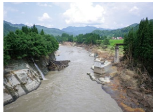
第7只見川橋りょう
