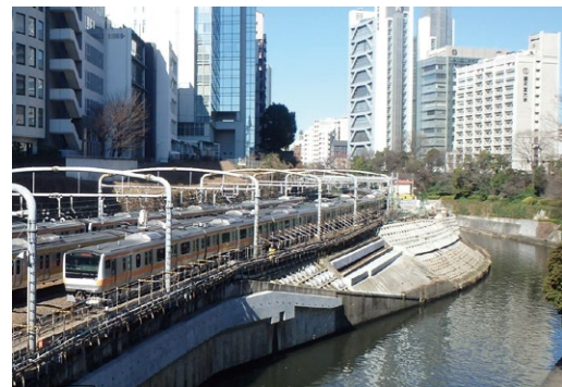
盛土耐震補強
