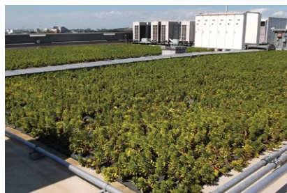
千葉支社ビルの屋上緑化
