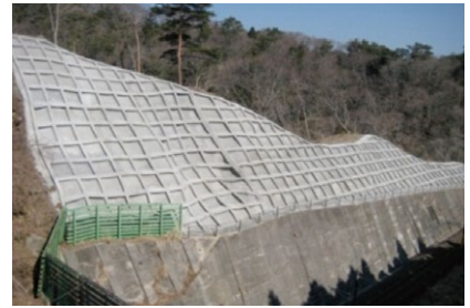
自然斜面防護工 (吹付砕工)
