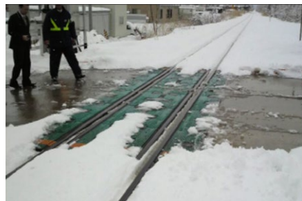
降雪地帯で交通量が多い踏切等に対してロードヒーティング等を整備。
