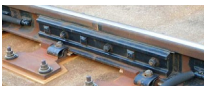
改良前の接着絶縁継目
