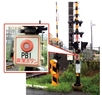
踏切支障報知装置
