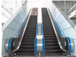
上下両方向のエスカレーター
