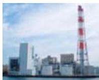
2006年6月に川崎火力発電所3号発電機の燃料を灯油から天然ガスへ転換
