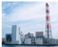
2006年6月に川崎火力発電所3号発電機の燃料を灯油から天然ガスへ転換
