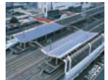
高崎駅のホーム屋根に設置された太陽光パネル
