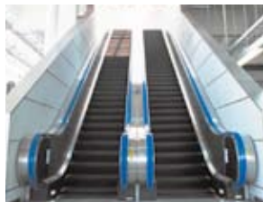
上下両方向のエスカレーター
