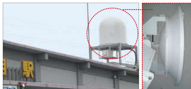
羽越本線・余目駅屋上に設置されたドップラーレーダ
