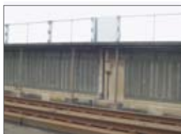
吸音板取付け
