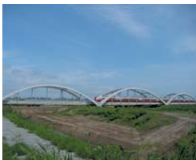
連続したコンクリートアーチ橋を採用し、青森の山々の景観との調和を図った東北本線上北町～乙供間の天間川橋りょう
