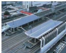
高崎駅のホーム屋根に設置された太陽光パネル
