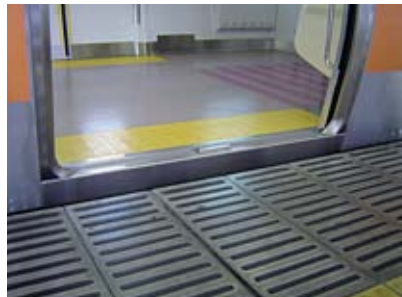
ホームとの段差を小さくした出入口
