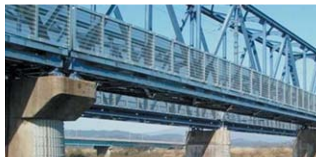
第2最上川鉄橋に設置した防風柵
