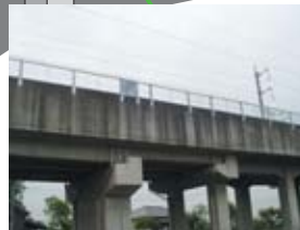
防音壁かさ上げ
