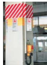
列車非常停止警報装置の「非常停止ボタン」(ホーム柱に設置)
