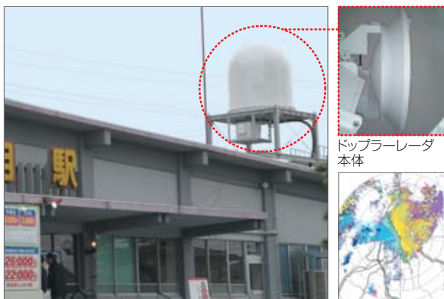
羽越本線・余目駅屋上に設置されたドップラーレーダ
