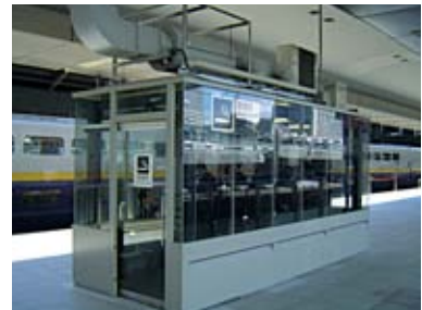
排煙設備を備えた新幹線ホームの喫煙ルーム
