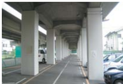
新幹線高架橋柱耐震補強を計画的に推進しています
