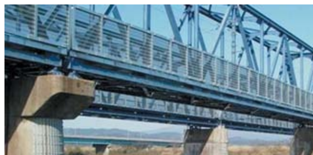
第2最上川鉄橋に設置した防風柵
