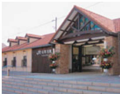
街づくりと連携して外観を改装した中央本線山梨市駅
