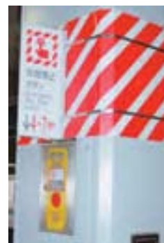
ホーム柱に設置してある「非常停止ボタン」を扱うことにより、運転士に危険を知らせます
