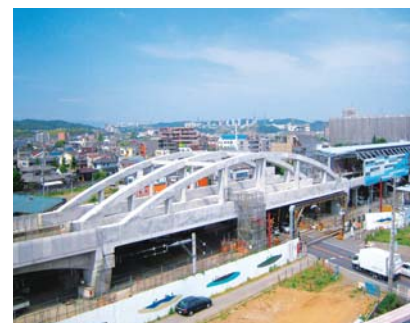
前後の高欄に桁高を一致させることにより、連続性のあるデザインとした南武線矢野口橋りょう。複線三主桁のランガー橋は日本初
