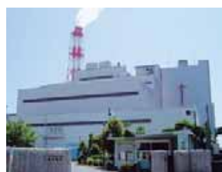
川崎火力発電所では、3号機の燃料を灯油から天然ガスに転換の予定
