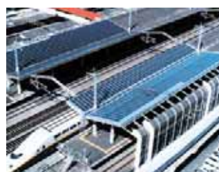
高崎駅の新幹線ホームの屋根に設置された太陽光パネルは、駅の照明や空調に電力を供給
