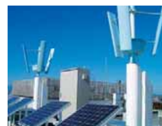
国分寺駅ビル「エル」の屋上の風力発電施設。発電量は館内に備え付けられたスクリーン画面で確認ができる
