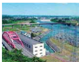
地震で被災し、復旧を急ぐ信濃川水力発電所
