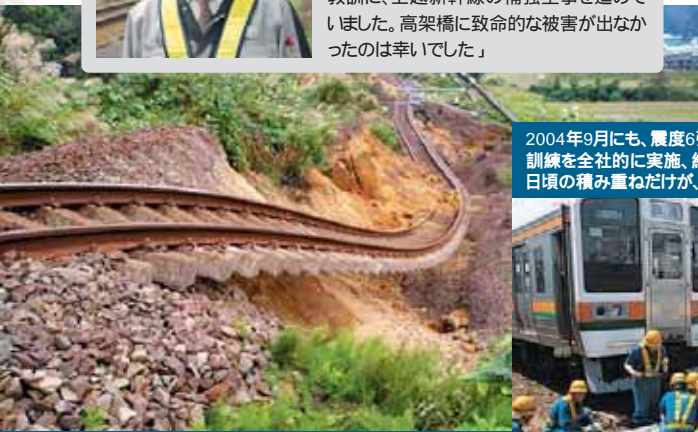
在来線区間でも数多くの箇所が被災。二次災害に注意しながら被災状況の確認が行われた
