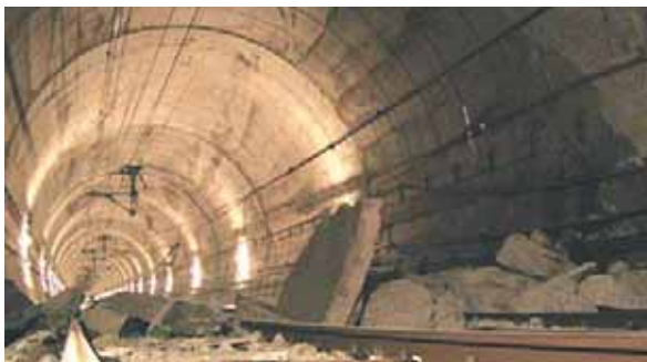
上越新幹線魚沼トンネルの入り口から約2.4km付近の様子。被災状況は一般的な考え方を遥かに超えたものだった
