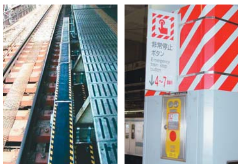
駅のホームでは、転落検知マット(左)や緊急停止スイッチ(右)のほか、さまざまな安全対策を講じています
