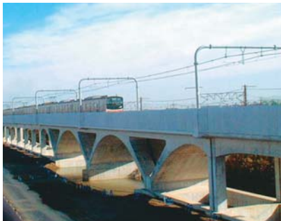
南越谷～吉川間の橋りょうではV字橋脚を採用することで周辺環境との調和を図っています
