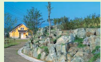
自然石を用いた擁壁と軽石舗装の緑道
