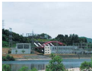
千手、小千谷、新小千谷の3カ所で、最大合計45万kWの発電能力を誇る信濃川発電所
