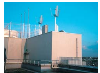
国分寺駅ビル「エル」の屋上に設置された風力発電機。発電量は館内に設置されたスクリーン画面で確認できます
