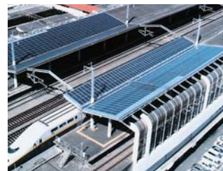
太陽光パネルの設置箇所が2倍になった高崎駅の新幹線ホーム
