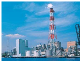
川崎火力発電所。老朽化した4号発電設備を高効率高出力の複合サイクル発電設備に取り替える予定です
