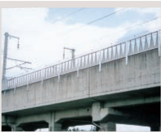
騒音低減と車窓からの視界確保に配慮した山型防音工
