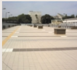
ピンを再生した舗装タイル (上野駅東西自由通路)
